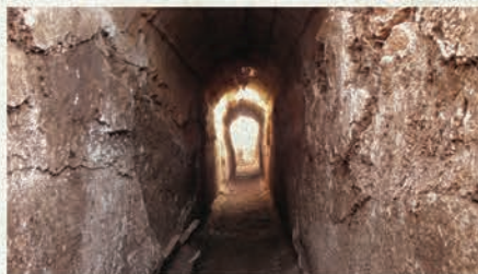
Εσωτερικό του αγωγού στην περιοχή της Σκάλας Λούρου
