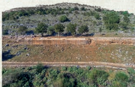
Άποψη του αναλημματικού τοίχου στην περιοχή της Στεφάνης
